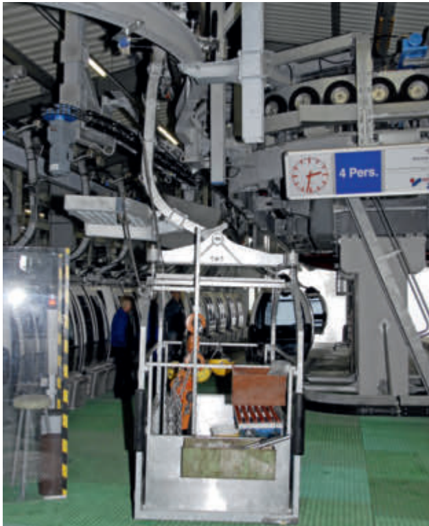
Abb. 1: Montagefahrzeug, aufgenommen im Zuge des Ortsaugenscheins in der Position unmittelbar vor der später beschriebenen Entgleisungsstelle
