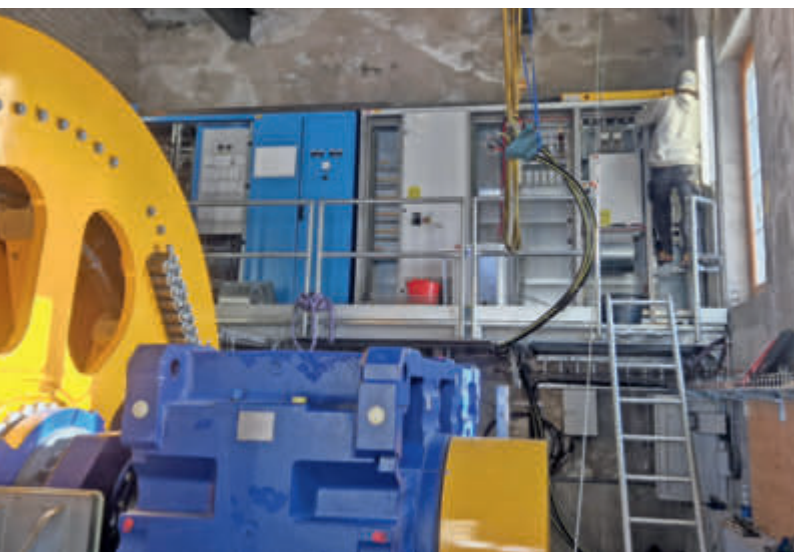
Innerhalb von 14 Tagen konnte der bestehende Frequenzumrichter vom Typ ACS 600 durch den neuen Typ ACS 880 ersetzt werden.
