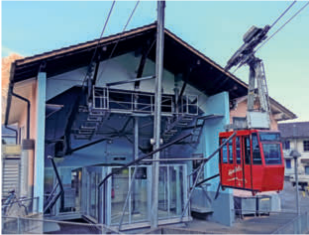
Im Rahmen der Modernisierung der Pendelbahn Schattdorf-Haldi wurde das AURO -System der Doppelmayr-Gruppe implementiert.
