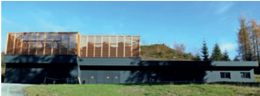
Die Wasserleistung der Pumpstation Seidlalm 2 wurde von 220 l/s auf 330 l/s erhöht. Ihre neue, mit einem Lärchenzaun eingehauste Kühlturmanlage verfügt über eine Gesamtkühlleistung von 360 l/s.
