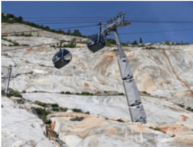
Die Stütze Nr. 3 wurde mit Matten versehen, um sie vor Beschädigungen durch Steinschlag zu schützen.
