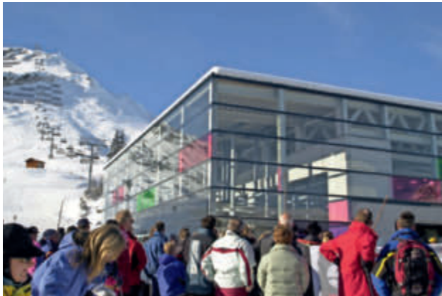
Lors de la nouvelle construction de la station aval du téléphérique du Kriegerhorn en 2002, on a choisi pour la façade de la gare des panneaux photovoltaïques spéciaux (2002).
