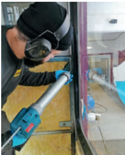
Arbeiten an der Innenverkleidung
