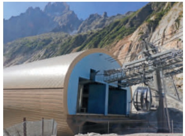
Die moderne Talstation der neuen 10er-Kabinenbahn befindet sich in der Nähe des Gletschers.
