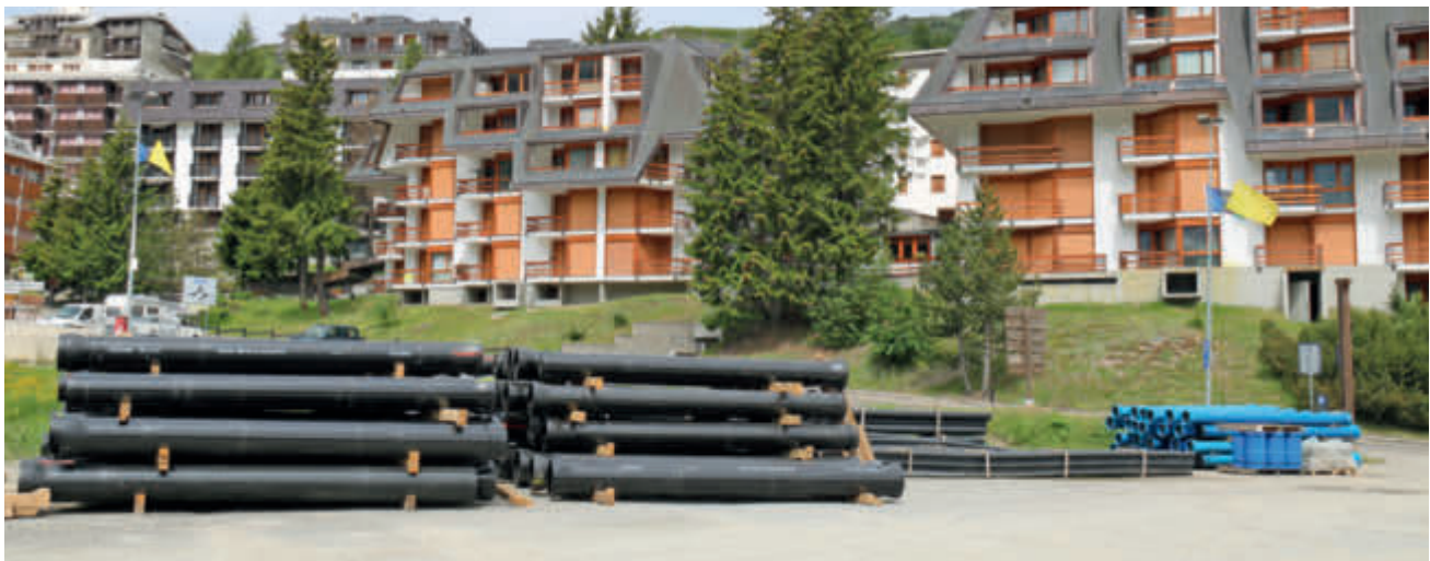
Dieses Jahr wurden im Skigebiet Sestriere 8.620 m duktile Gussrohre in den Dimensionen DN 100 bis 400 und Nenndruckstufen von PN 63 bis PN 85 verbaut – im Bild das Lager in Sestriere.
