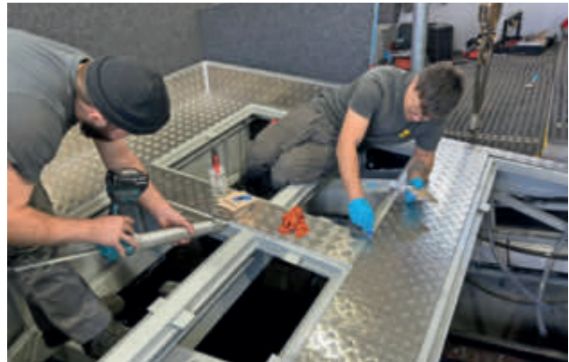
Der neue Riffelblech-Boden nimmt Formen an
