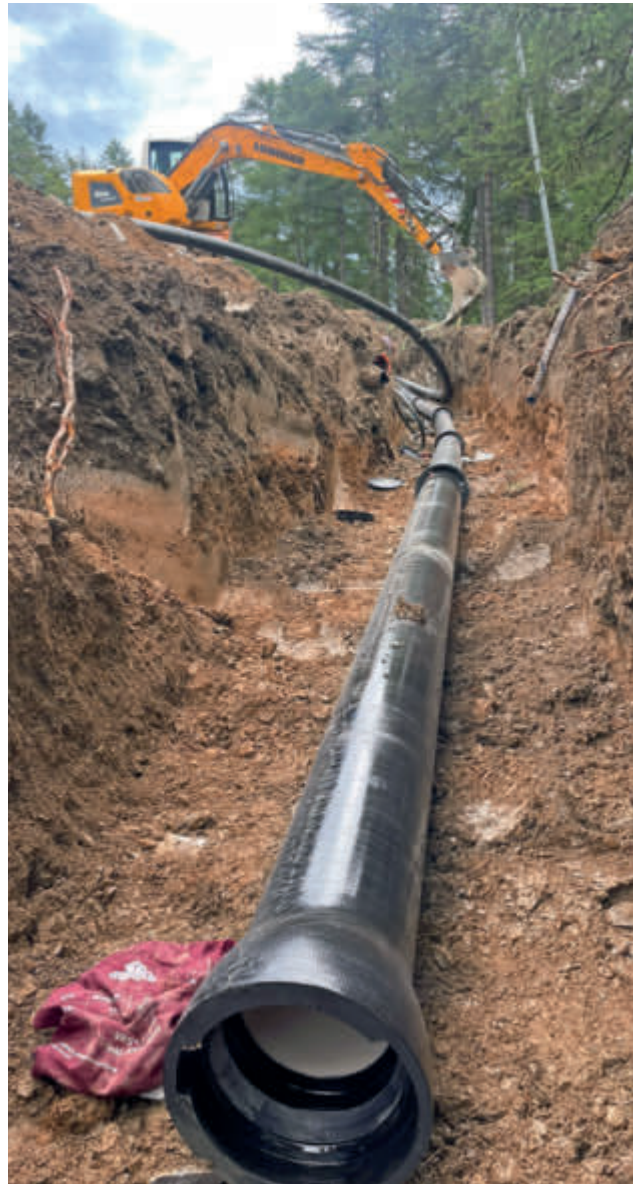
VRS®-T-Verbindungssystem: Dadurch, dass die Muffen wie ein Kugelgelenk ausgeführt sind und je nach Dimension bis zu 5° abwinkelbar sind, hat man beim Verlegen mehr Flexibilität und Spielraum.
