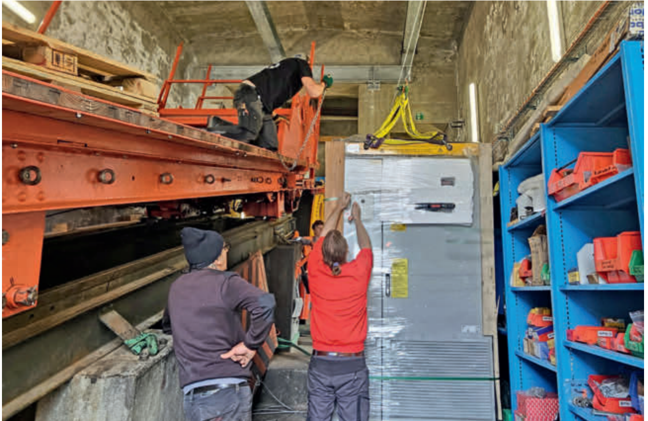
Enge Platzverhältnisse in der Bergstation erforderten Präzisionsarbeit.
