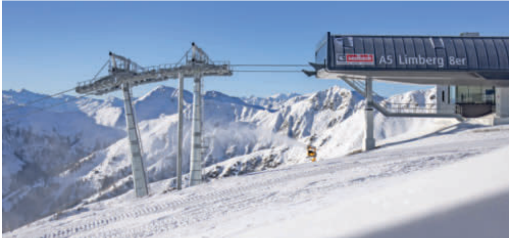
Eines der großen Projekte 2023 für Melzer & Hopfner war die neue 8er-Sesselbahn Limberg in Saalbach.
