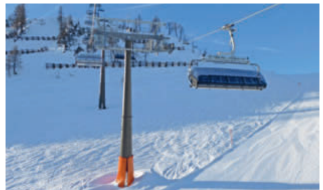
Vue sur la ligne du nouveau télesiège lors de la montée
