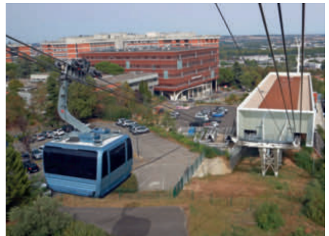
Die Mittelstation Hôpital Rangueil
