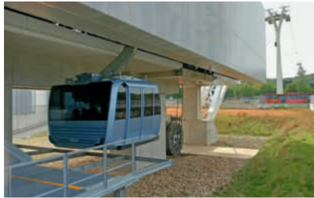
Die Station Université Paul Sabatier . Hinter der Kabine ist die Trageilreserve zu sehen.
