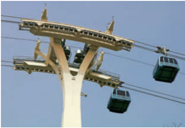
Der Stützenkopf der Stütze Nr. 4 mit Kabinen im Detail
