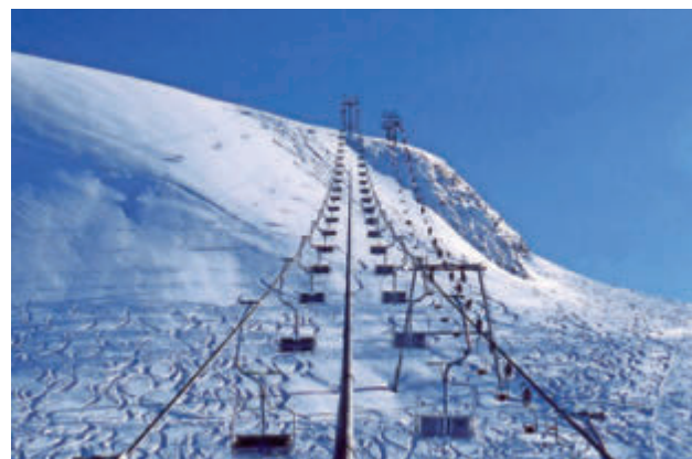
Fig. 3 : Partie supérieure du tracé du télésiège biplace Gefrorene Wand IIIa, vu de la tête du pylône supérieur sur glacier. A droite, le tracé du télésiège monoplacement, pratiquement parallèle au télésiège biplace.
