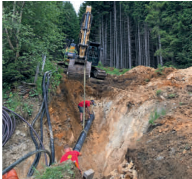
Bei den Feldleitungen kamen die duktilen Gussrohre von TRM zum Einsatz.
