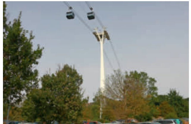
Die Stütze Nr. 1 ist 70,5 m hoch.
