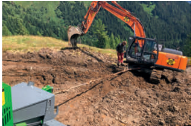
Beim Feldleitungsbau hatte man oft mit Schlechtwetter und viel Regen zu kämpfen. Darum wurden die Bagger mittels einer Traktionshilfsseilwinde (li. im Vordergrund) bergwärts und dann auch wieder talwärts gezogen.
