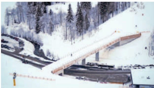
Im WM-Ort Hinterglemm wurde die skitechnische Anbindung bei der 12er Nord mit einer neuen Skibrücke optimiert.
