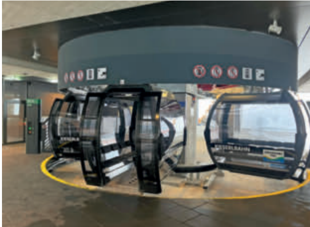
Die neue Kieserlbahn I + II ist für den autonomen Betrieb ohne Personal in der Tal- und Bergstation ausgelegt.
