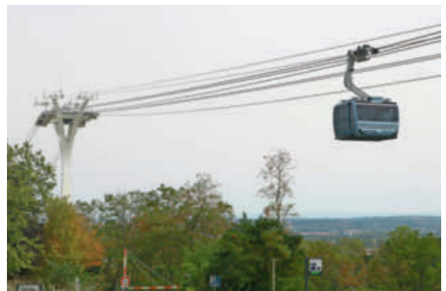
Die Strecke bei der Mittelstation Hôpital Rangueil , links die Stütze Nr. 4
