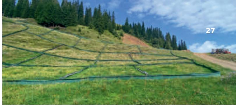
Zum Schutz von Amphibien- und Reptilienarten wurde im Vorfeld der Pistenbaumaßnahmen eine Absiedelung durchgeführt. Hierfür wurden rund 3.000 m Fang- und Sperrzäune aufgestellt und die rund 340 Stück aufgestellten Fangkübel täglich kontrolliert. Im Bild: Fangzäune im Bereich der Damenabfahrt.
