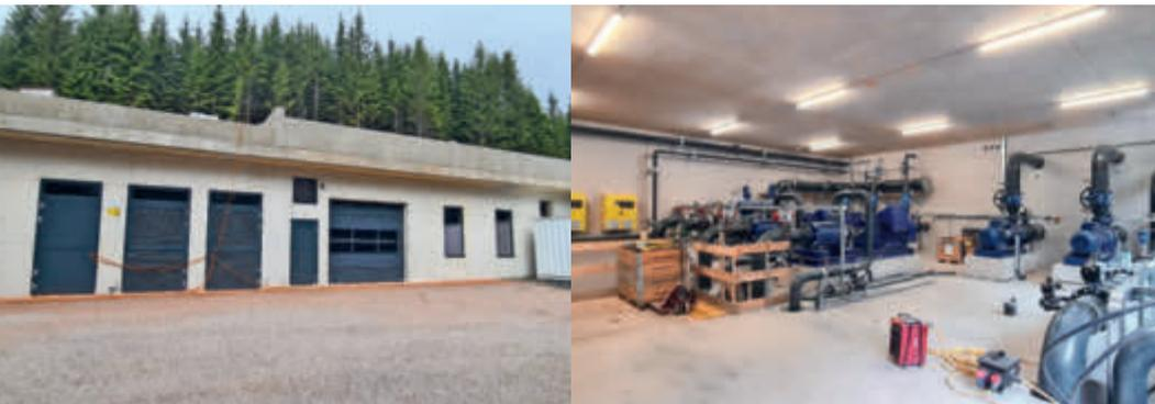
Die neue *Pumpstation Breitfussalm II* ist derzeit auf eine Wasserleistung von 315 l/s ausgelegt, aber ist auf einen Durchsatz von 420 l/s erweiterbar.
