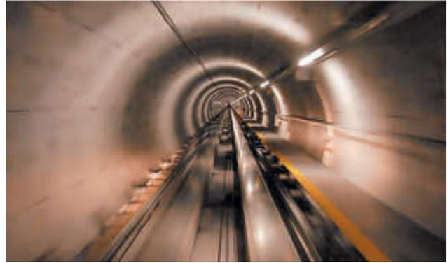
Gleis im Tunnel der *Skymetro* von Poma-Otis am Flughafen Zürich, aus dem fahrenden Zug fotografiert. Die Fahrzeuge gleiten bei diesem System mit Luftkissen auf einer glatten Betonfahrbahn.
