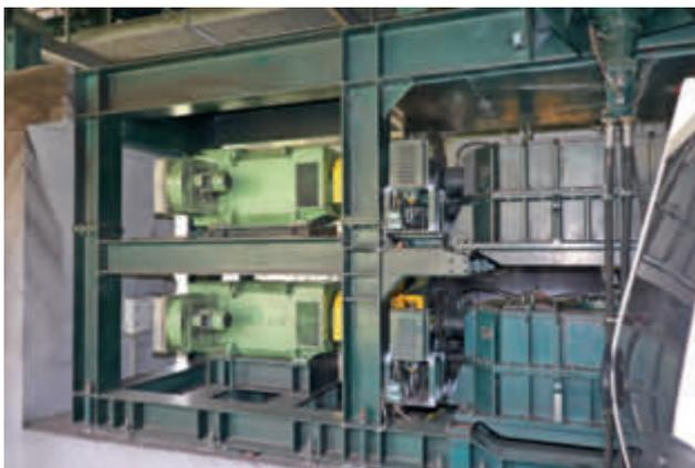
Antrieb der 12er-Kabinenbahn Laghi Cime Bianche mit zwei 330 kW-E-Motoren (links) und zwei Getrieben (rechts)
