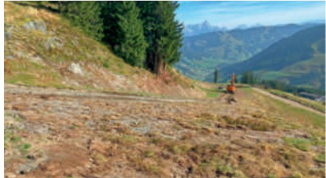
Damenabfahrt: Im oberen Streckenabschnitt wurde eine Engstelle adaptiert, um die notwendige Pistenbreite sowohl für die Streckenführung, als auch für die Errichtung der erforderlichen temporären Sicherungsmaßnahmen mittels A-Netzen zu gewährleisten.
