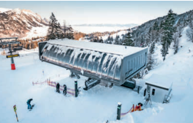
Pilotanlage für AURO für Sesselbahnen im Schweizerischen Wildhaus. Im Bild ist die Bergstation Oberdorf-Freienalp zu sehen.
