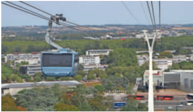
Téléo in Toulouse (F) von Poma ist die weltweit dritte urbane 3S-Bahn und längste Stadtseilbahn Frankreichs. Sie nahm im Mai 2022 den Betrieb auf.
