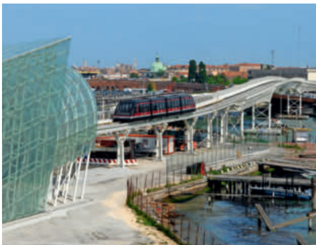
Beispiel für die Überwindung geografischer Hindernisse: Der „People Mover“ von Venedig, eine seilbetriebene APM-Anlage, überbrückt zwei Kanäle auf der Strecke von einem Parkhaus auf der Insel Tronchetto zum Piazzale Roma im Zentrum Venedigs.
