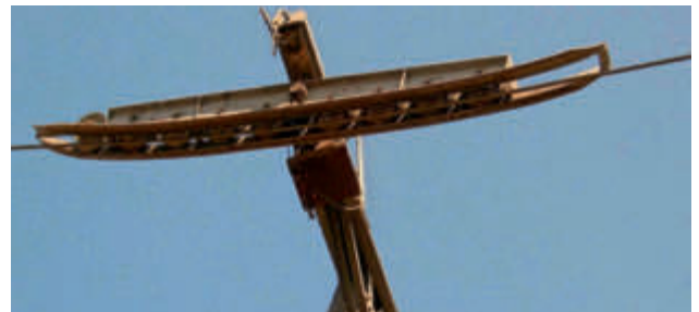
Abb. 2: Bei den Niederhaltestützen ist ein Schienenpaar beiderseits der Seilrollen angebracht, auf dem die Laufräder der Klemmapparate aufsetzen und entlanglaufen.
