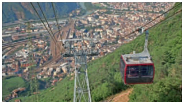
Als erste urbane 3S-Bahn kann die 4.560 m lange und seit 2009 im Betrieb befindliche Rittner Seilbahn Bozen – Oberbozen (ITA) von Leitner bezeichnet werden.
