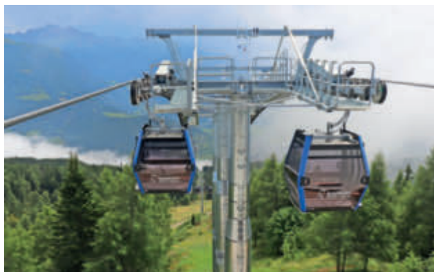
Blick auf die Diamond-EVO -Kabinen der Rosskopfbahn vor der Bergstation
