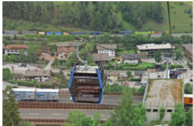
Die Schutzbrücke der Überquerung der Brennerautobahn konnte auch für die neue Kabinenbahn weiterverwendet werden.
