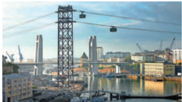
Die Pendelbahn in Brest war Frankreichs erste urbane Seilbahn (2016). Bei der von Bartholet entwickelten Technologie kreuzen sich die Seilbahnkabinen übereinander.
