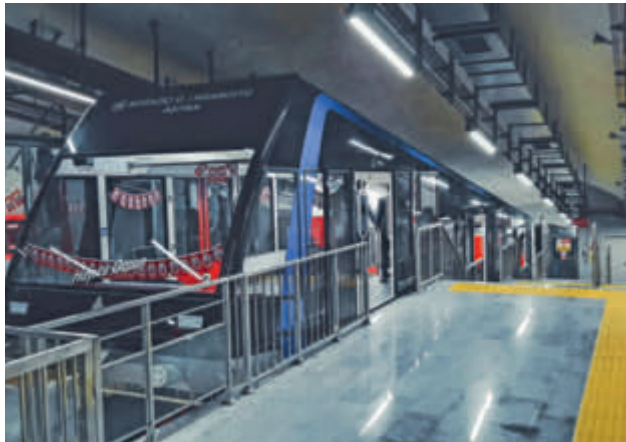
Rumeli Hisarüstü-Aşiyen Füniküler , eine 200er-Standseilbahn (Garaventa) im Tunnel, ist komplett in das öffentliche Verkehrsnetz Istanbuls integriert.
