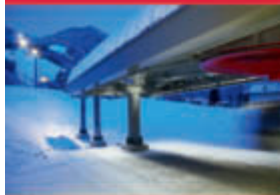
Palüdbahn Brand, Vbg.
