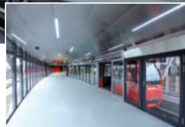
Die SQUAIRE Metro in der Station
