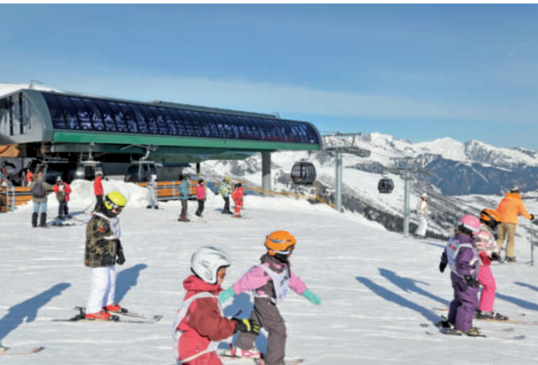
Gare amont de la télécabine Pierrafort
