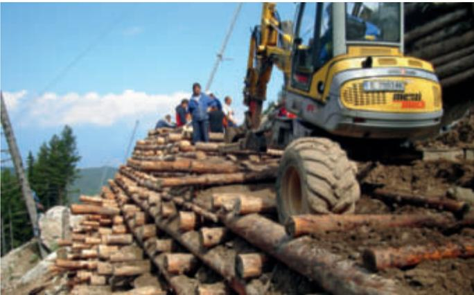
Bei der Stabilisierung labiler Bereiche setzte man auf ingenieurbiologischen Bauwerke aus Holz und Pflanzen anstelle von Beton und Stahl, z. B. eine Holz-Krainerwand an der berühmten Tomba-Abfahrt.
