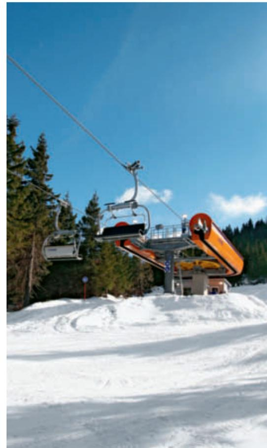
Die kurze Station von Leitner als fixe Umlenkstation für kuppelbare 4er- und 6er-Sesselbahnen mit niedriger Stationsverkleidung
