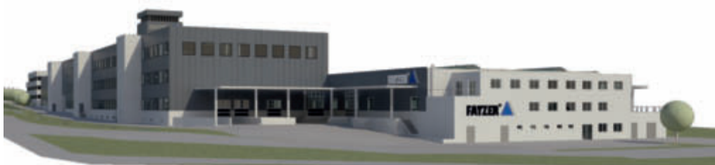
Presentación de la ampliación completa de la Planta II de Fatzer.
