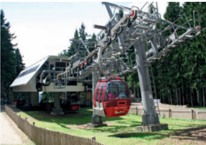
Diese 6er-Kabinenbahn von der Harzer Brauanlage zum Wurmberg ersetzte im Jahr 2000 zwei Teilstrecken einer zweiplätzigen Von-Roll-Kabinenbahn aus den 60er Jahren in der gleichen Trasse. Die gegenwärtige Bahn hat eine Mittelstation (im Bild), verfügt aber über nur einen Antrieb und eine durchgehende Förderseilschleife.
