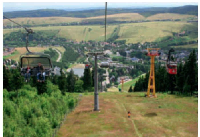
Parallel zur Pendelbahn wurde im Jahr 1999 diese 4er-Sesselbahn mit Wetterschutzhauben auf den Fichtelberg gebaut. Für die Seilbahntechnik zeichnete die Firma Girak-Garaventa in Zusammenarbeit mit der deutschen Firma Heuss verantwortlich. In den letzten Jahren werden auch mehrere Varianten einer Seilbahnverbindung zum naheliegenden tschechischen Klínovec (Keilberg, 1.244 m ü M.) diskutiert.
