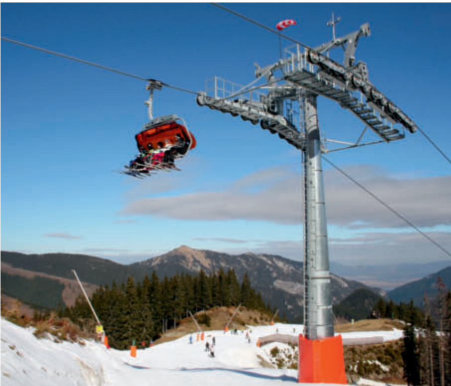
Stütze nahe der Bergstation Priehyba der 6er-Sesselbahn von Záhradky; auf dem Bild ist gut zu erkennen, wie wichtig eine leistungsfähige Beschneigungsanlage in einem schneearmen Winter ist.
