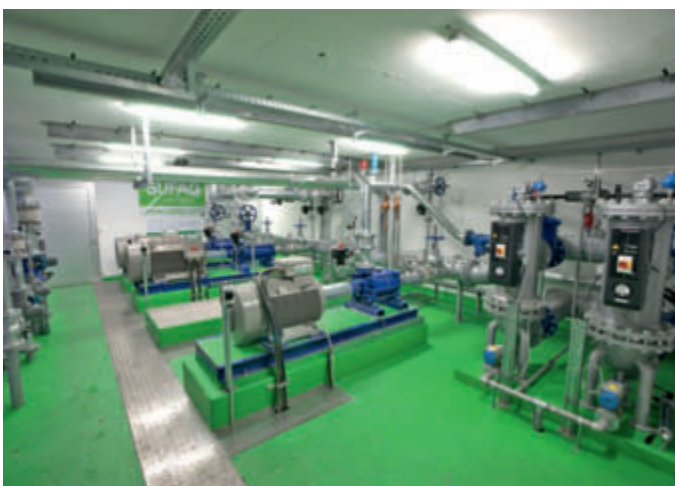
Pumpstation „Läger“ der Beschneigungsanlage Grindelwald Männlichen
