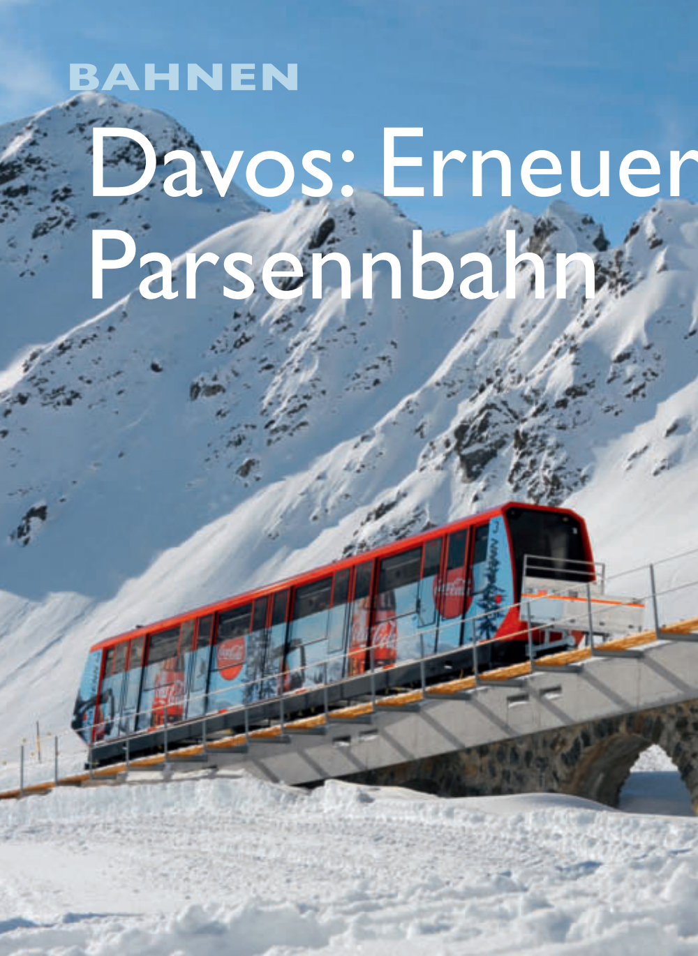
Im Winter 2010/2011 konnten die Fahrgäste zum ersten Mal auch an der 2. Teilstrecke der Parsennbahn zum Weissfluhjoch mit diesen modernen Wagen von Gangloff fahren.
