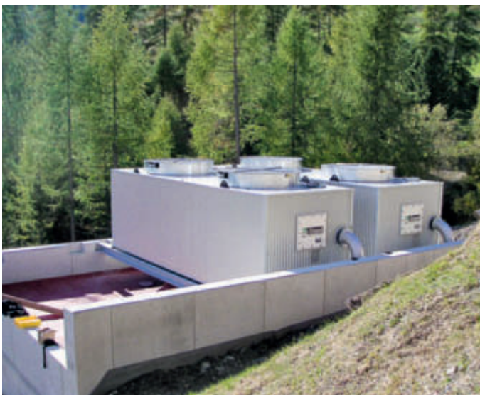
Ausbau der Kühlstation „Schlattain“ im Jahr 2010
