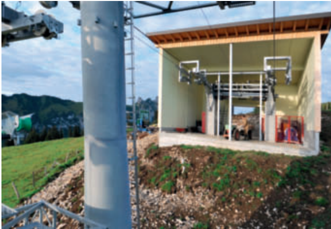
Blick in die Wagenhalle der Bergstation
