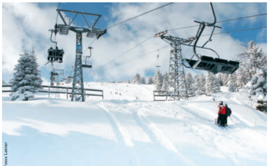
Die zu ersetzenden Anlagen in Savognin
