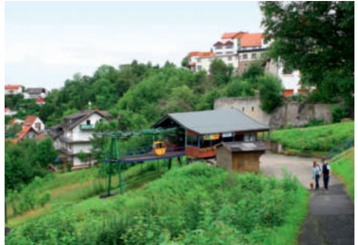
Die „Waldecker Bergbahn“ mit ihren 28 2er-Kabinen wurde genau vor 50 Jahren von der deutschen Firma Pohlig (später Pohlig-Heckel-Bleichert) gebaut. Auf einer nur 650 m langen Trasse erschließt sie das Schloss und den Luftkurort Waldeck am Ufer der Talsperre Edersee – im Bild die Bergstation.
