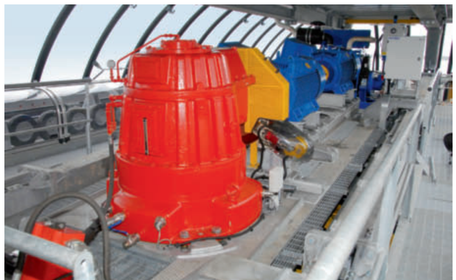
Frequenzgeregelter Drehstromantrieb mit zwei Motoren in Tandemanordnung in der Bergstation der „Mairerbahn“
