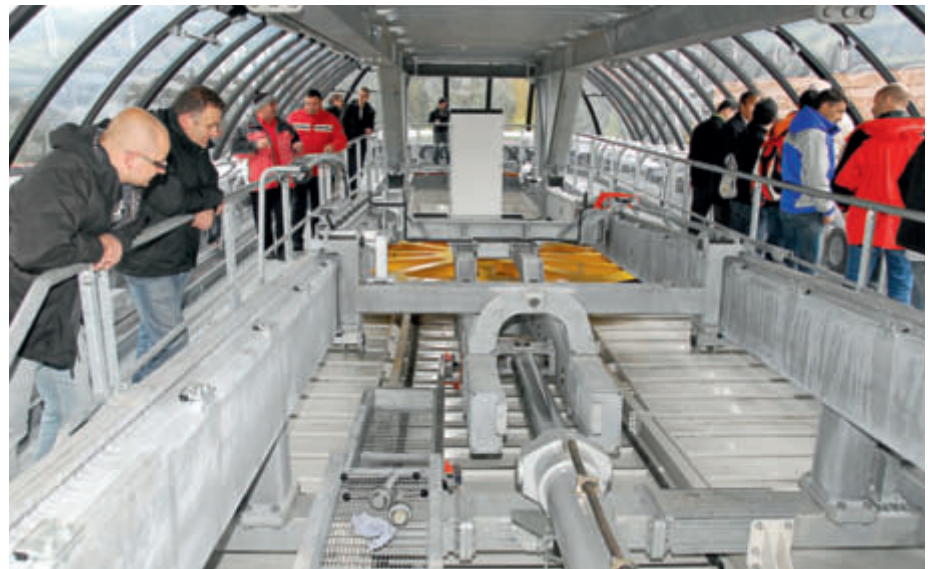
Spanneinrichtung in der Talstation der „Mairerbahn“
