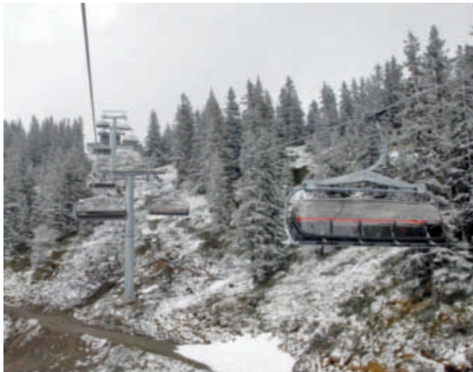
Strecke der „Ochsalmbahn“ in Richtung Bergstation
