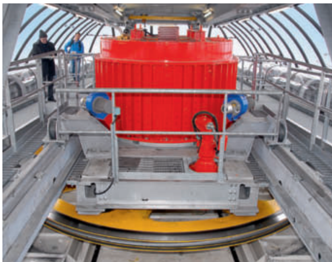
Direktantrieb in der Bergstation der „Ochsalmbahn“
