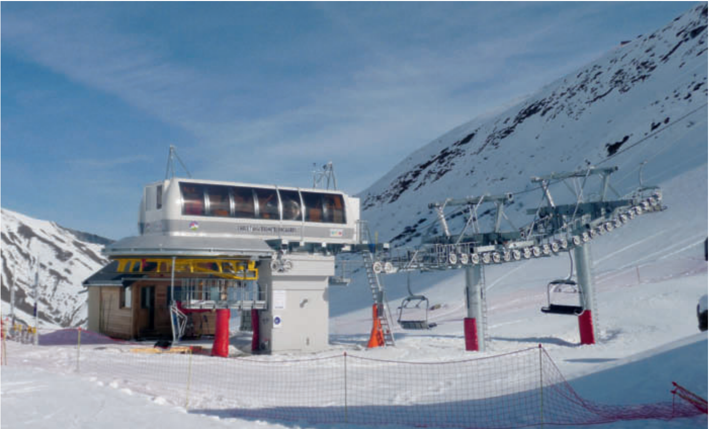
Télesiège pinces fixes 4 places du Chalet de la Balme Blanchards Saint Sorlin d'Arves – Domaine des Sybelles
