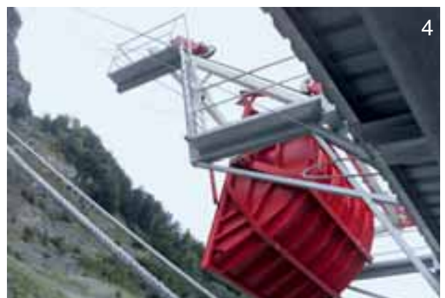
Bild 1: Bergfahrt der Lastmulde auf der extrem steilen Trasse mit einer durchschnittlichen Neigung von knapp 50°.
