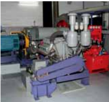
Der Antrieb der Kronbergbahn mit Antriebsmotor, mit Diesel-Notantrieb und mit der zweifelligen Antriebssscheibe befindet sich in der Bergstation.
