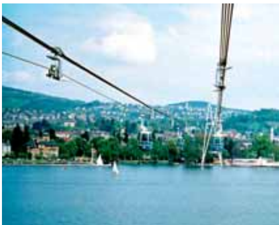
Die Anlage führte in 20 m Höhe über den hier 1 km breiten Zürchersee und verband die beiden Teile der Gartenbauausstellung.
