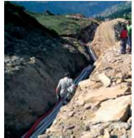
Bauarbeiten für die 15 Schneilanzen des Typs A9 auf der Riederalp
