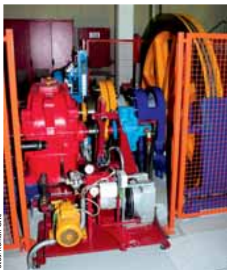
Der Antrieb mit der zweirilligen Antriebsscheibe wurde revidiert und teilweise saniert.
