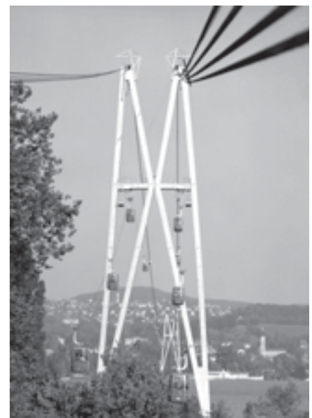
Blick auf die Pylonen in Längsrichtung der Bahn
