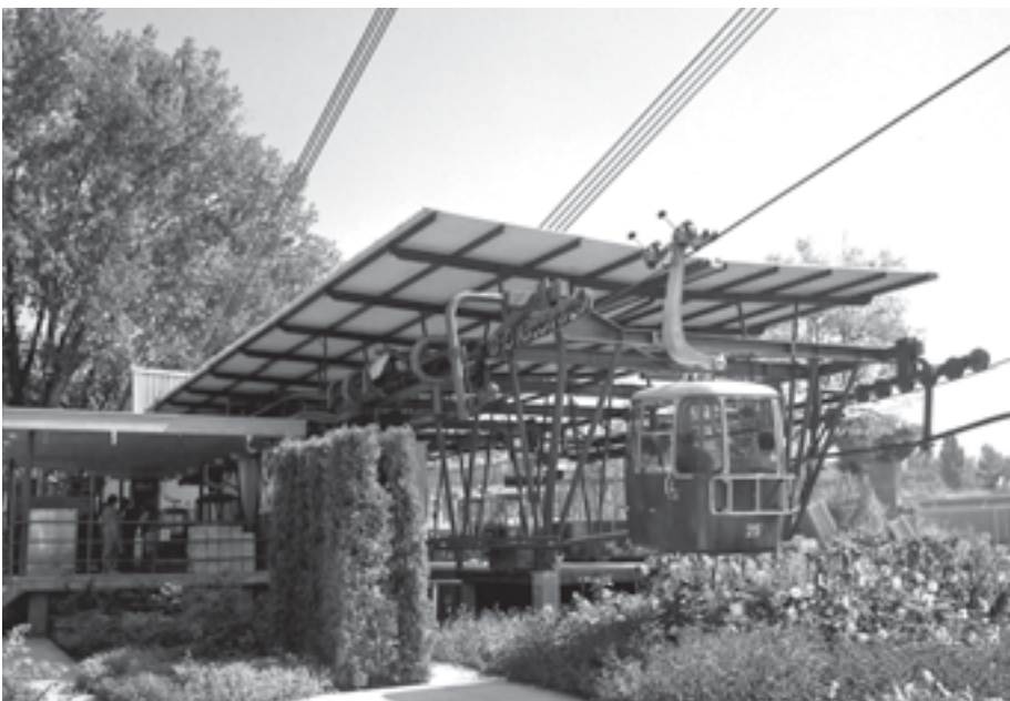
Die luftige, leichte Konstruktion der Stationsbauwerke fügte sich gut in die Gartenbauausstellung ein.
