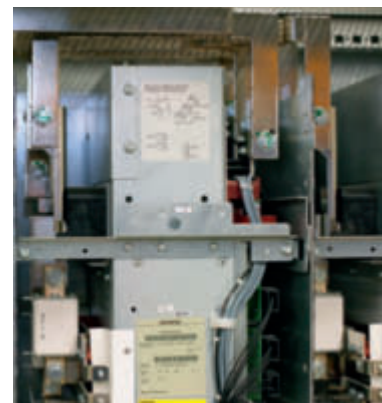
Abb. 2: AC-Umrichter von Siemens mit Active-Infeed-Technologie
