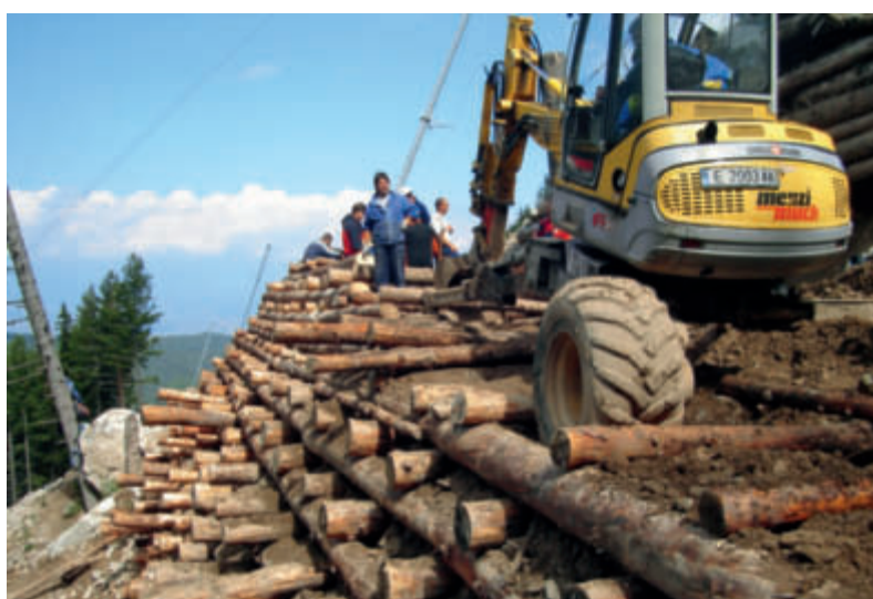
Для укрепления нестабильных участков вместо бетона и были использованы инженерно-биологические конструкции из дерева и растений, например специальная подпорная стенка из бревен на знаменитом горнолыжном спуске Томба.
