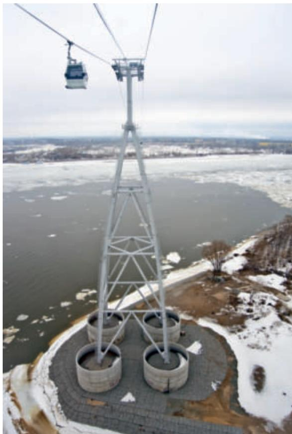
Две из 10 опор имеют высоту 82 метра и вес 170 тонн каждая
