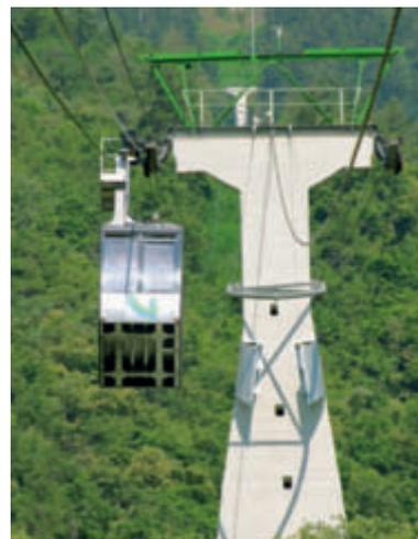
**39 Fachwerkstützen der ersten Bahn wurden im Jahr 1953 durch nur mehr vier Stahlbetonstützen ersetzt, die auch bei der heutigen Bahn weiterverwendet wurden. Bild: Stütze Nr. 1 mit einer Kabine.**
