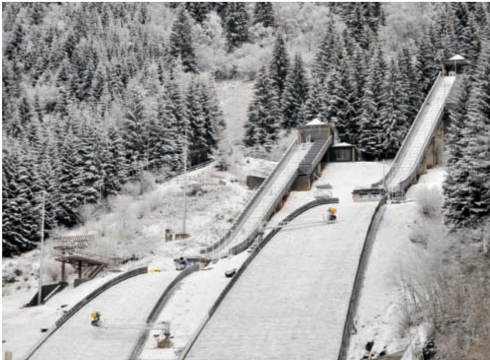
Die beiden M12 auf Arm wurden zwischen den beiden Ausläufen der Groß- und Kleinschanze angebracht. So können beide Ausläufe mit den selben Schneeerzeugern beschneit werden.
