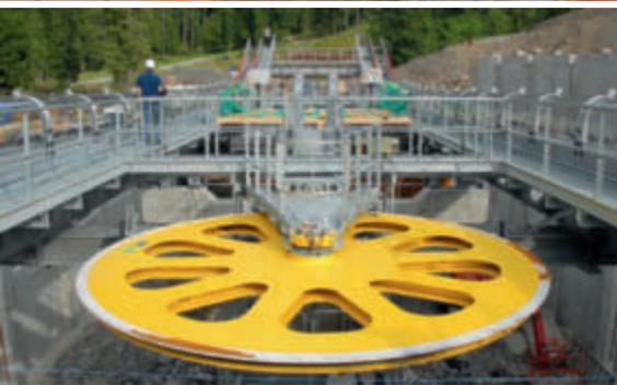
**Bild 3:** Am Lager der fixverankerten Umlenkscheibe ist die Einrichtung zur Messung der Zugseilspannkraft in der fixverankerten Zugseilschleife angeordnet.
