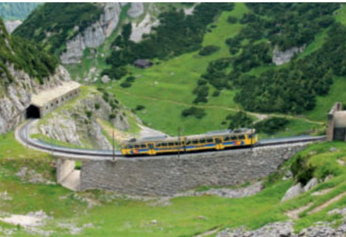
Zu den spektakulärsten Bauwerken der Wendelsteinbahn gehört die so genannte Hohe Mauer mit 130 m Länge und 17 m Höhe.
