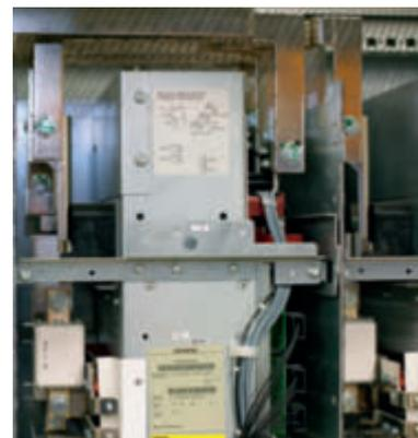
Abb. 2: AC-Umrichter von Siemens mit Active-Infeed-Technologie
