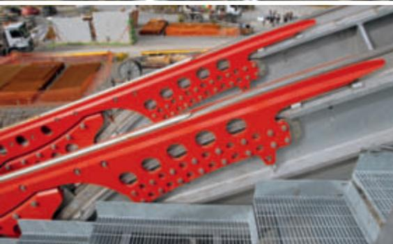
**Bild 5:** Ein interessantes Detail ist die Gestaltung des Fahrbahnüberganges von den Trageseilen auf die festen Schienen der Stationsein- und -ausfahrt.
