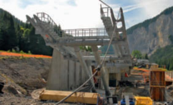
**Bild 1:** Abschnittsweise wird vor der Talstation im Zuge der Seilauflage das Trageseil magnetinduktiv geprüft und damit das Grunddiagramm erstellt, das zur Feststellung allenfalls bereits bei der Seilauflage vorhandener Seilfehler und zum Vergleich mit späteren magnetinduktiven Prüfungen dient.
