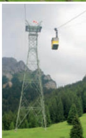
Die 2.953 m lange Trasse der Wendelstein-Seilbahn verfügt über eine einzige, 75 m hohe Stütze. Das längere erste Spannfeld misst 1.648 m.
