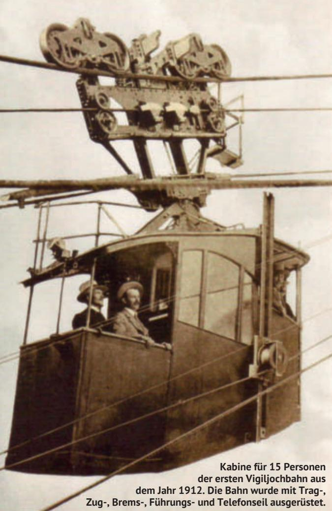
Kabine für 15 Personen der ersten Vigiljochbahn aus dem Jahr 1912. Die Bahn wurde mit Trag-, Zug-, Brems-, Führungs- und Telefonseil ausgerüstet.
