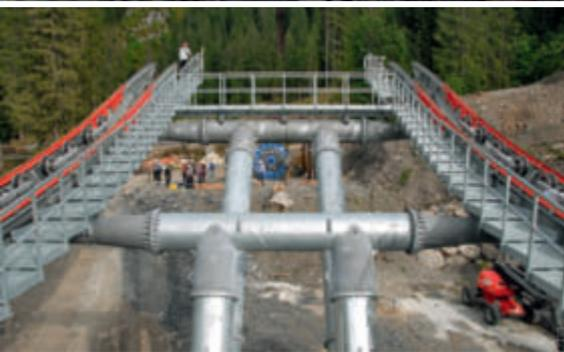
**Bild 4:** Im Bereich der festen Fahrbahnen der Stationsein- und -ausfahrt sind die Niederhalterollen für das Zugseil in gefederter 2er-Wippen gelagert.
