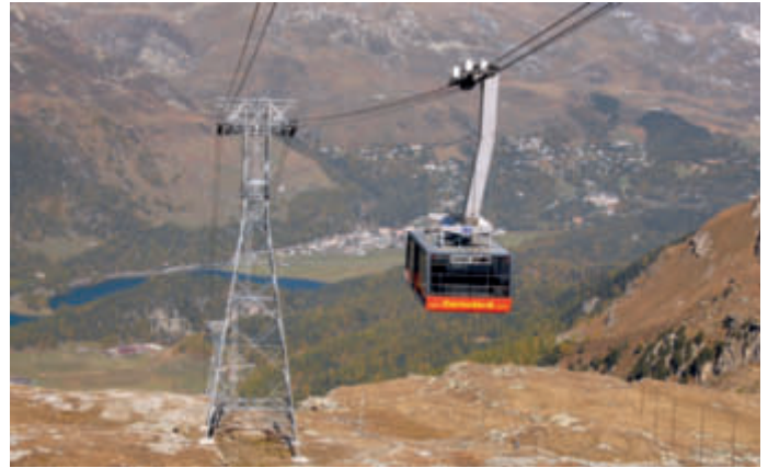
125er-Pendelbahnwagen der 1. Teilstrecke im Trassenbereich vor der Bergstation
