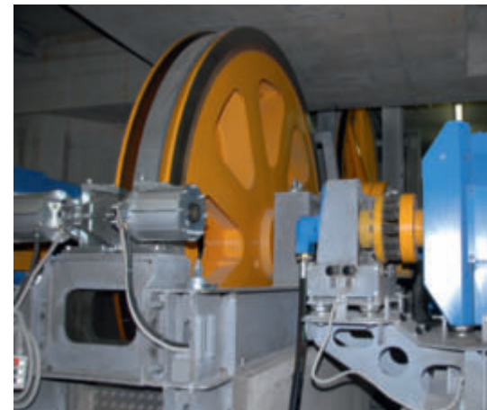
Rechts im Bild die Kupplung zwischen Ölmotor des Notantriebes und Hauptgetriebe, links je ein Element der pneumatischen Betriebs- und Sicherheitsbremse, die auf getrennte Bremskränze an der Antriebs-scheibe wirken.
