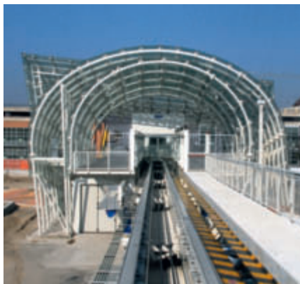
Überdachung der Station Tronchetto in Stahl und Glas
