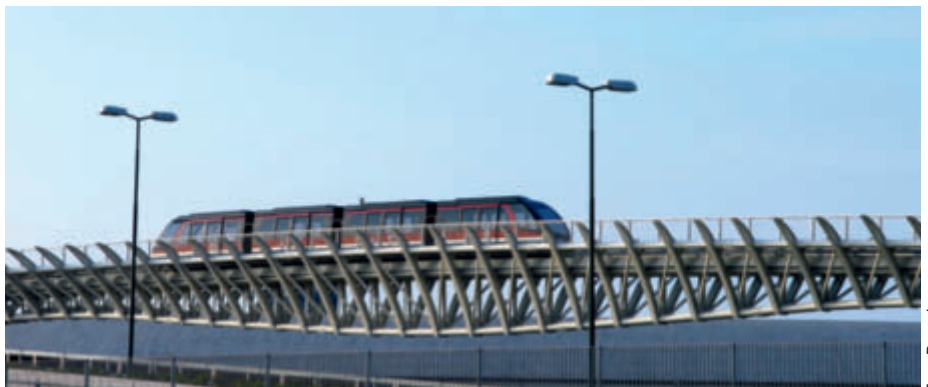
Der Untergurt – „Bauch der Möwe“ – der Brücke über den „Canale Columbuola“ ist dem Verlauf der Biegemomente angepasst..
