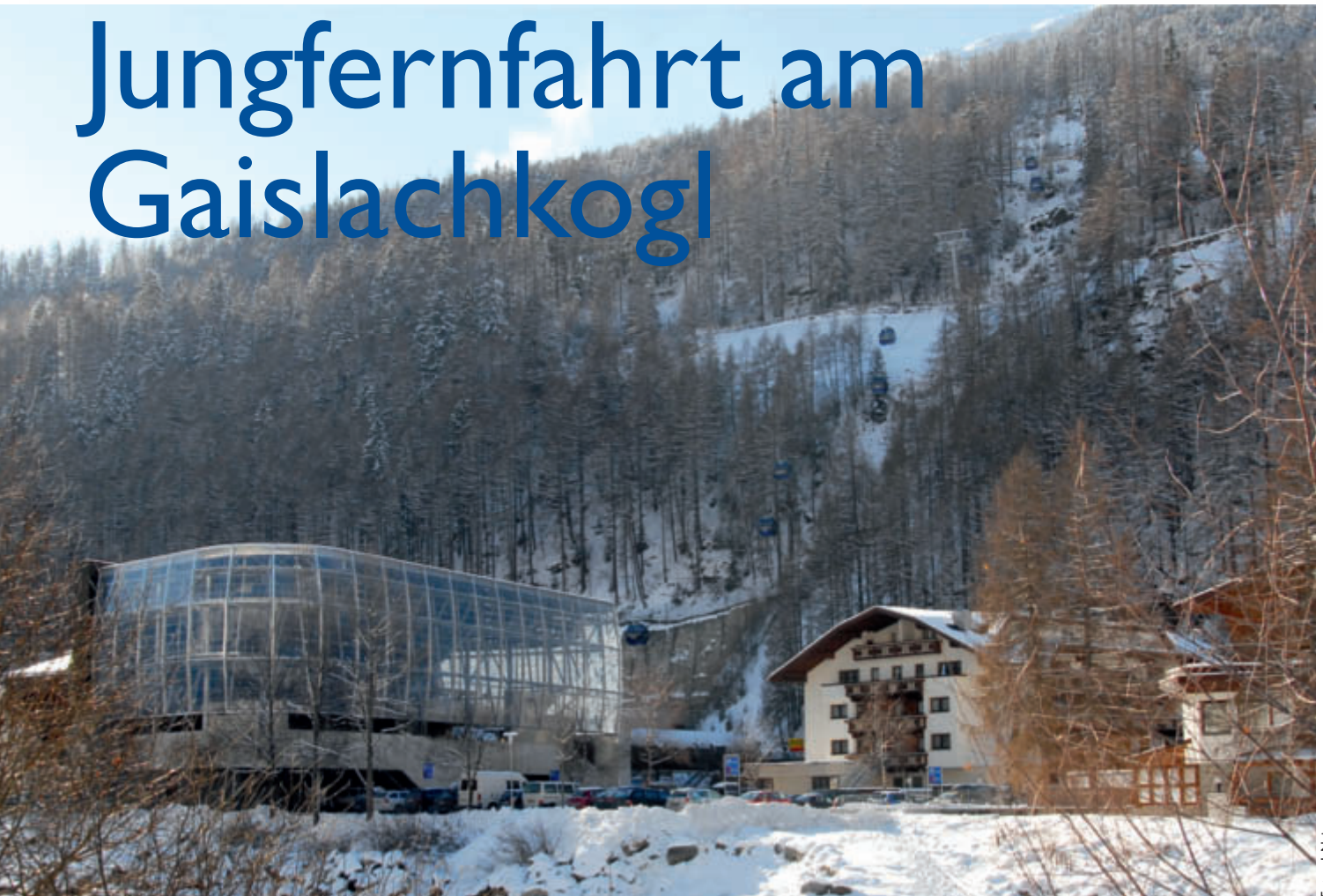
Bild 1: Talstation der neuen Gaislachkogelbahn mit Garagierung der Fahrzeuge im Obergeschoß
