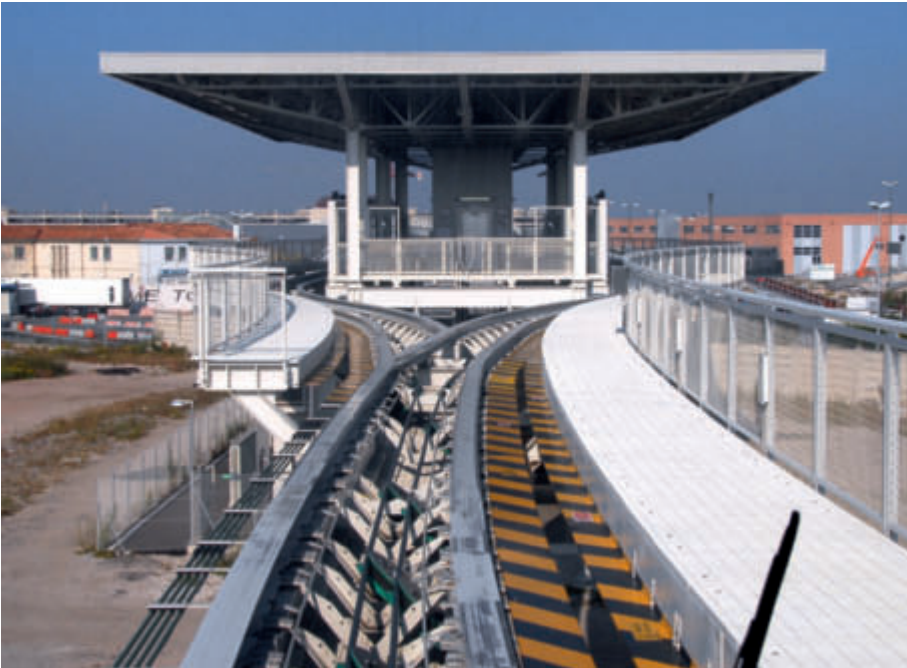
Fahrbahn mit Weiche vor der Mittelstation auf der Insel Marittima
