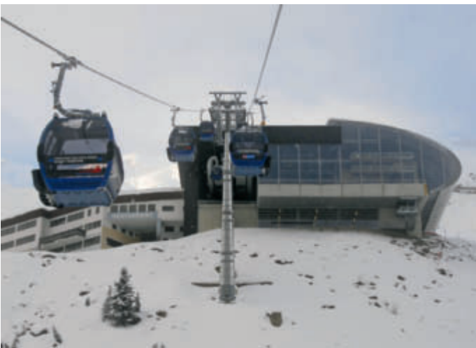
Bild 4: Einfahrt in die Mittelstation. Rechts neben der Einfahrt befindet sich der Bereich der 3S-Bahn-Talstation.
