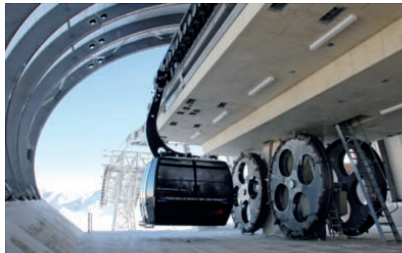
Bild 7: Einfahrt in die Bergstation der 3S-Bahn. Rechts im Bild die Spulen mit den Reservelängen der Tragseile.
