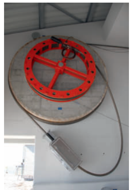
Ausleitung des Lichtwellenleiterkabels aus einem der vier Tragseile in der Bergstation der 2. Teilstrecke
