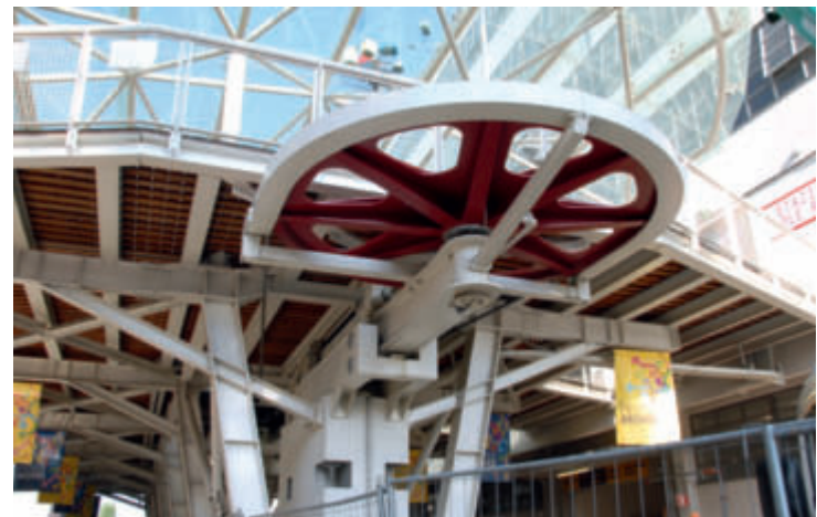
Die Station Piazzale Roma ist als Spannstation ausgeführt.
