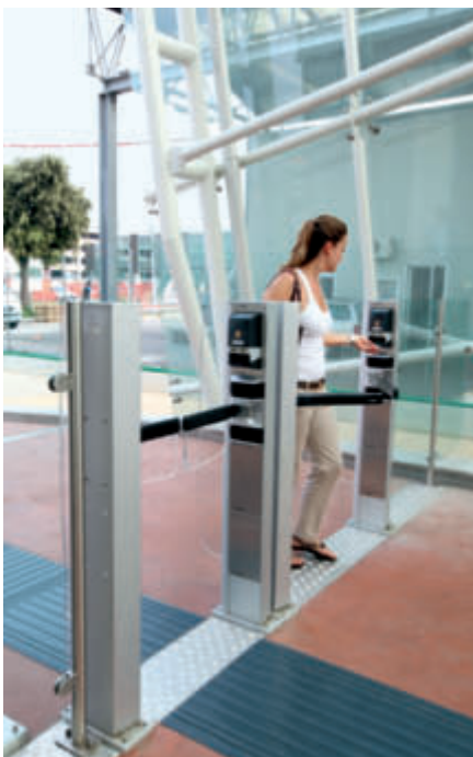
Das Zutritts-System (Flap Gates) wurde von Axess geliefert.
