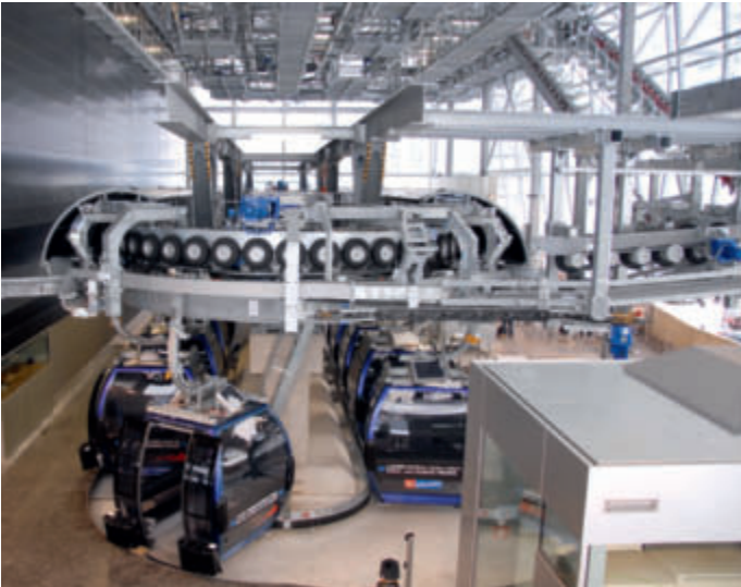
Bild 2: Blick in die Talstationshalle. Rechts im Bild die Schrägförderer zum oben liegenden Abstellbahnhof
