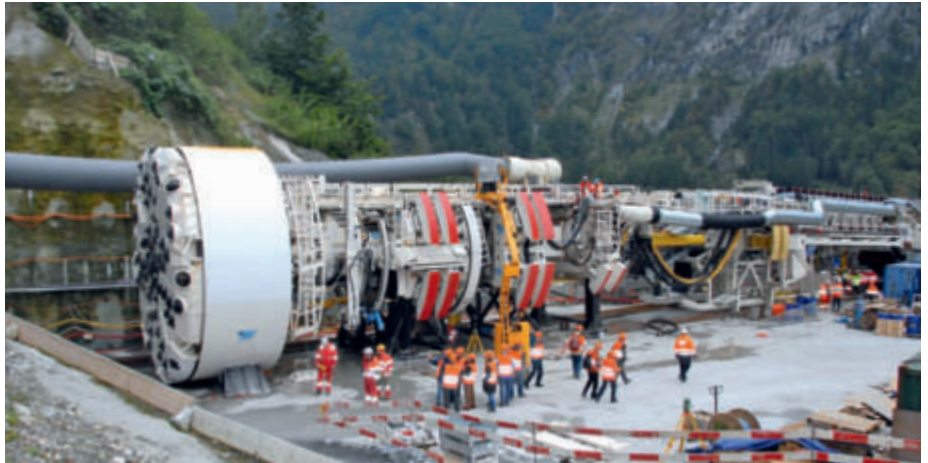
Tunnelier pour le funiculaire de desserte de la centrale pompage-turbinage de Limmern
