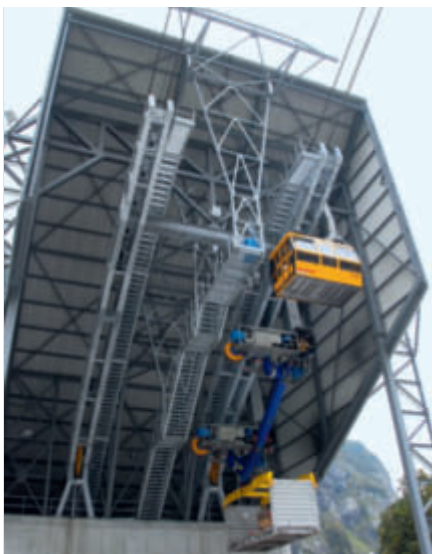
Gare aval du 1 er tronçon du téléphérique Garaventa destiné au transport de charges lourdes sur le chantier de la centrale de pompage-turbinage de Limmern.
