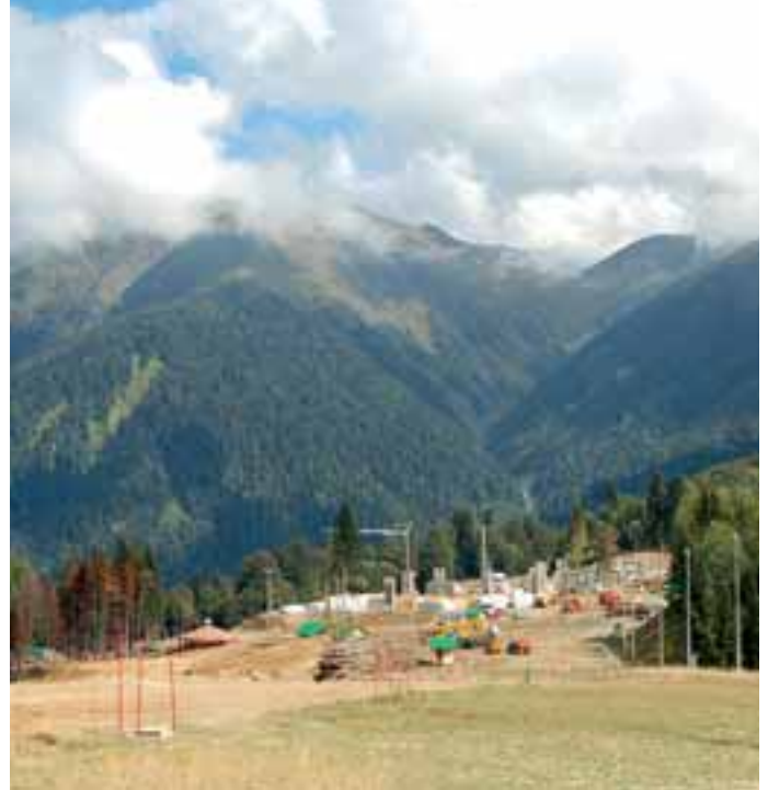
Bauarbeiten für die Beschneigungsanlage im Skigebiet „Grand Hotel Polyana“
