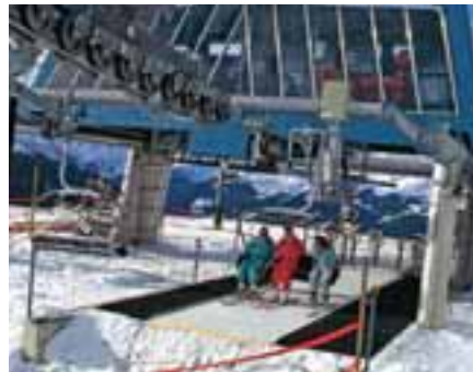
ChairkiD Einstiegsförderband an der Talstation der fixen 4er-Sesselbahn „Rossmoos“ in See vor 20 Jahren.
