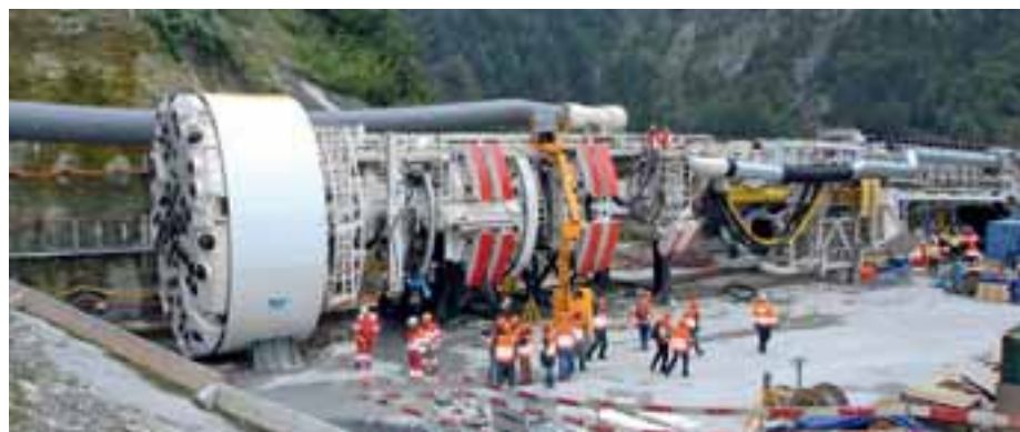
Tunnelbohrmaschine für die Versorgungs-Standseilbahn des Kraftwerks „Limmern“
