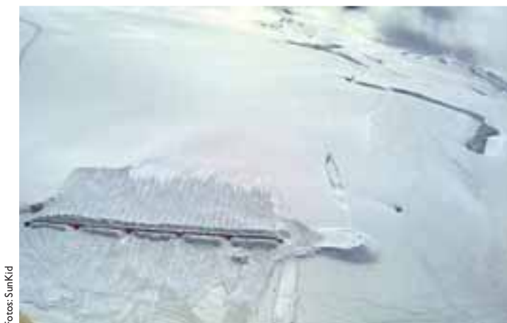
Im Bild deutlich zu erkennen: Durch das Heranschieben des Oberflächenschnees an die SunKid-Galerie wird diese durch den Schneedruck in ihrer Position gehalten.
