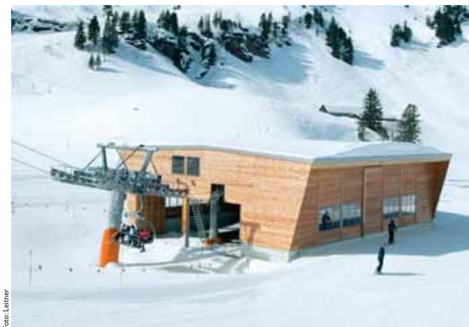
Talstation der kuppelbaren 6er-Sesselbahn „Seeben – Stellisattel“
