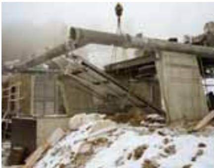
Montage des ChairKid Einstiegsförderbandes bei der Talstation auf 1.980 m Seehöhe
