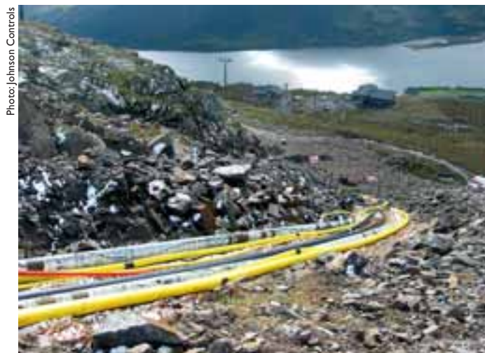
Travaux en cours à Åre.
