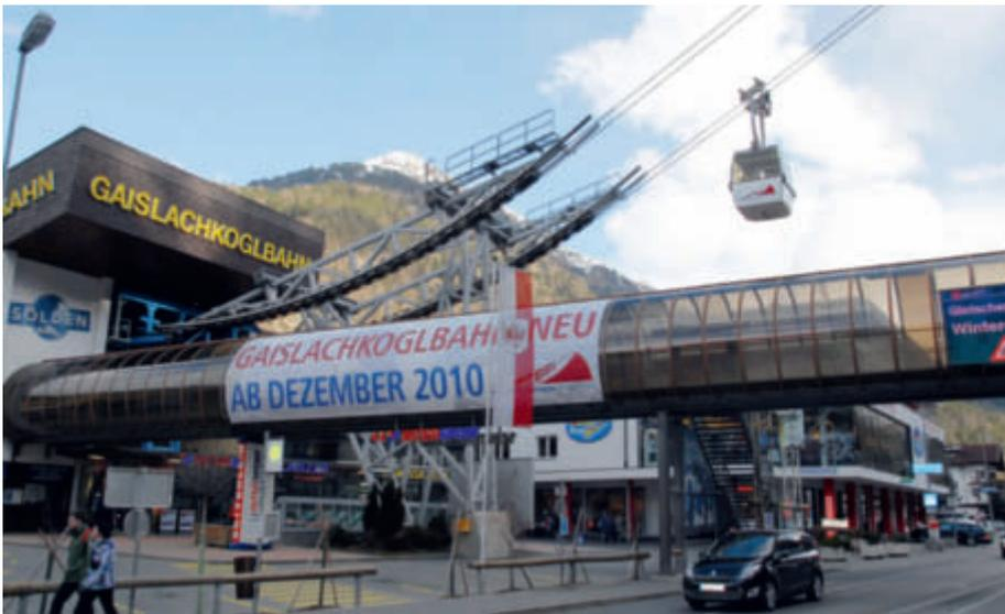
Eine der letzten Kabinen der Gaislachkoglbahn aus dem Jahr 1988 fährt in die Talstation ein. Bereits für den nächsten Tag war die Ablage des Zugseiles vorgesehen.
