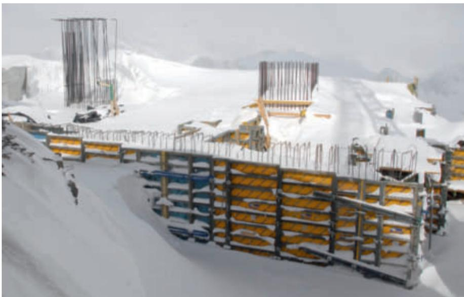
Die Fundamentierungsarbeiten für die neue Bergstation sind bereits weit fortgeschritten. Deutlich sind die beiden hochragenden Bündel von Bewehrungsseilen für die Schubnasen zu erkennen.
