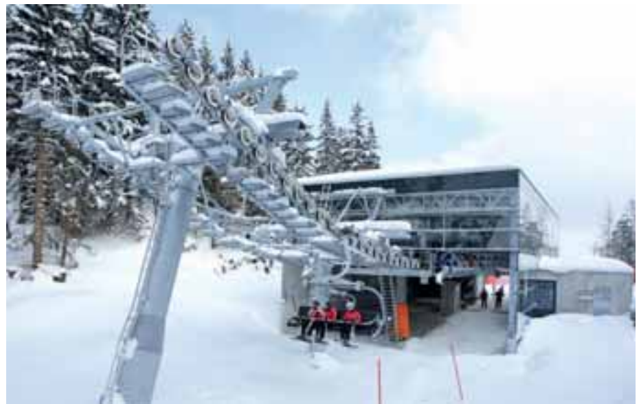
Ausfahrt aus der Talstation der 6er-Sesselbahn "Grubersunk"
