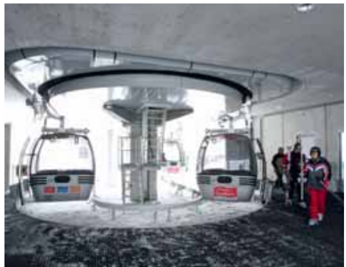
Umführungsbereich der Kabinen in der Bergstation der 8er-Kabinenbahn „Gsoll“
