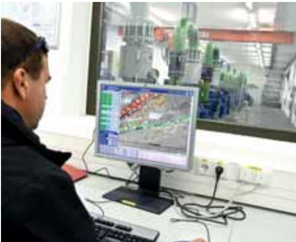
ATASSplus bringt die gesamte Beschneiungsanlage auf den Bildschirm und ermöglicht eine effiziente und bequeme Steuerung.
