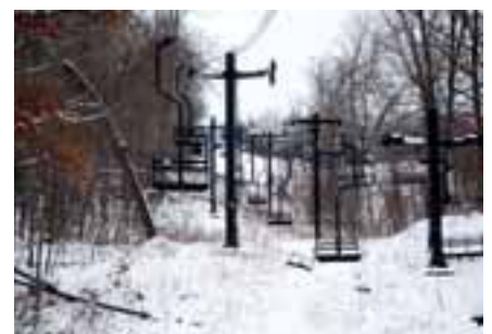
Förderseilentgleisung auf der Talfahrtseite der Doppelsesselbahn, rechts im Bild die 3er-Sesselbahn der Parallelanlage
