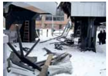
Die Beschädigungen in der Talstation
