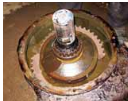
Blick in das geöffnete Hauptgetriebe
