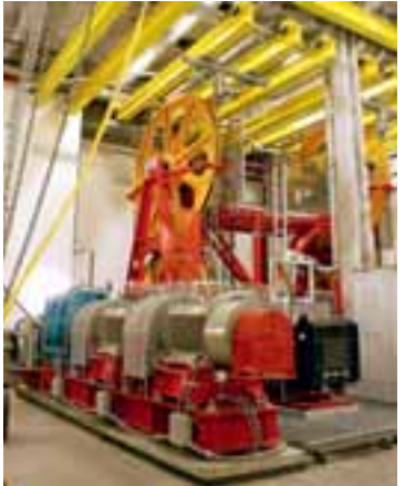
Der Antriebsraum mit den zwei unabhängigen Antriebssätzen für die Parallelanlage
