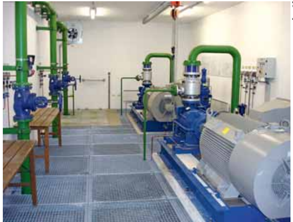
Pumpenraum mit zwei parallelen Pumpensätzen und Teilen des Kühlsystems der Station Grünwald
