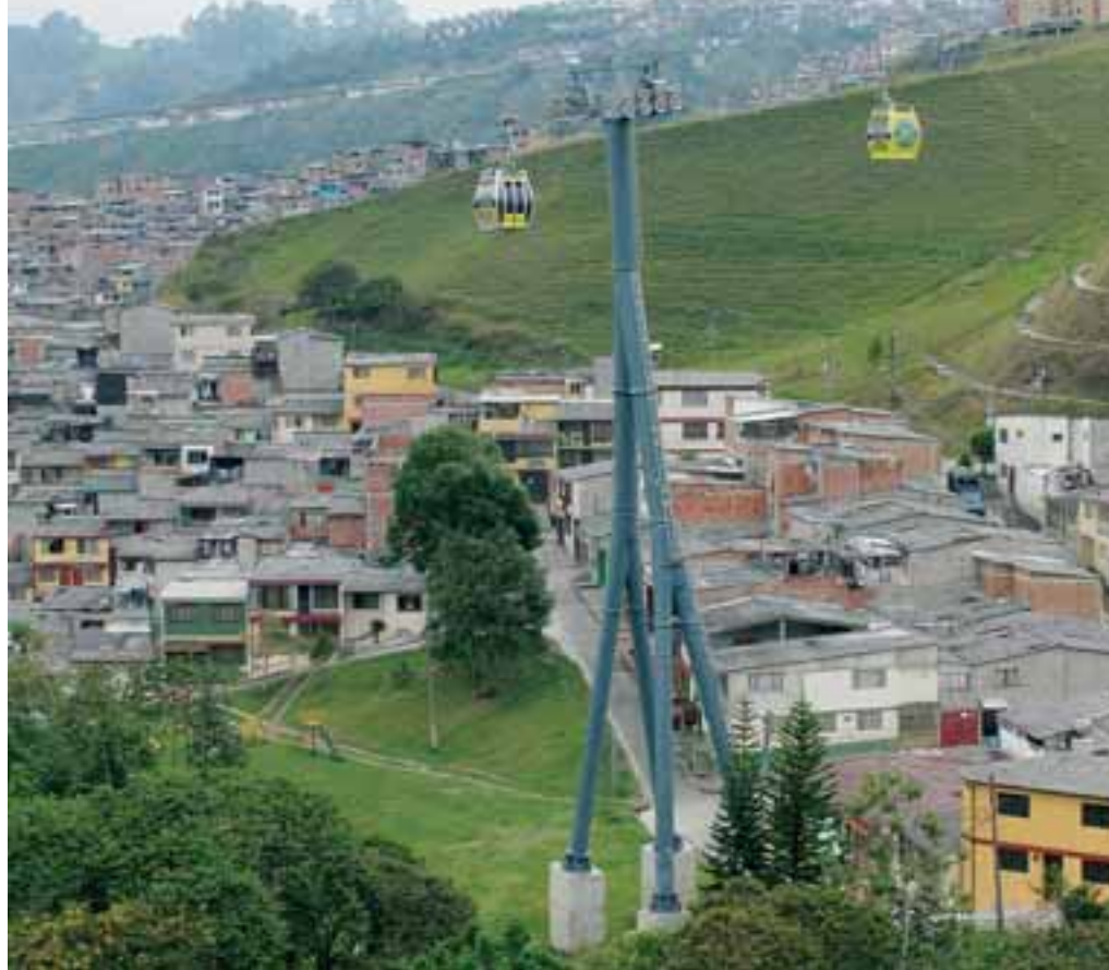
Interessante Stützenkonstruktion in Rohrbauweise: Der oberste Teil des Stützenschaftes verzweigt sich in zwei Rohrschäfte, die dann nochmals eine Gabelung in je zwei Stützenfüße aufweisen.
