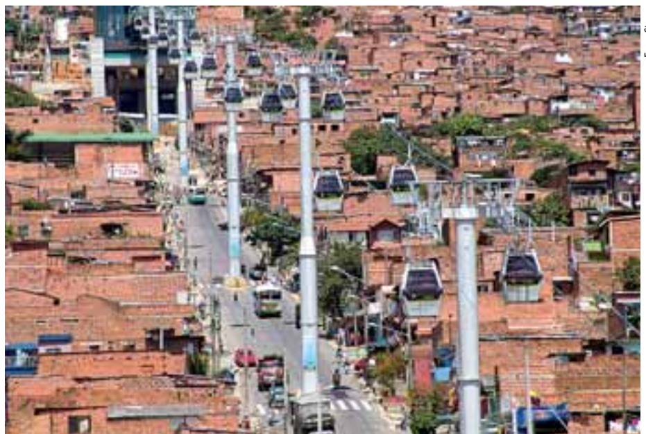
Anbindung eines Vorortes der kolumbiatischen Stadt Medellin an eine U-Bahnstation mittels einer Kabinen-Einseilumlaufbahn.
