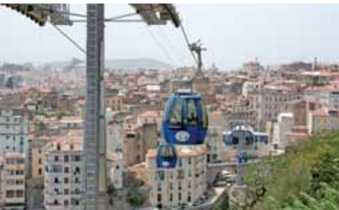
15er-Kabinenbahn „Constantine“, Entreprise du Métro d'Alger, Constantine, Algerien
