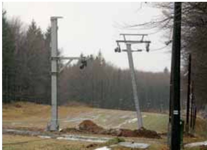
Bauarbeiten auf der Trasse im Skigebiet Kékes
