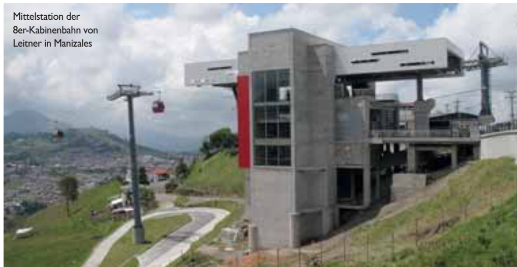
Interessante Stützenkonstruktion in Rohrbauweise: Der oberste Teil des Stützenschaftes verzweigt sich in zwei Rohrschäfte, die dann nochmals eine Gabelung in je zwei Stützenfüße aufweisen.
