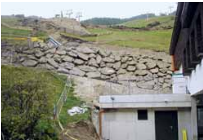
Pumpstation Rainstadt neben der Talstation der 8er-Kabinenbahn „Giggijoch“ mit Feldleitungsverlegung im Bildhintergrund
