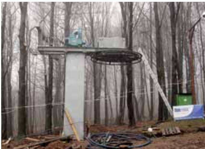
Bauarbeiten im Bereich der Bergstation eines der „neuen alten“ Schlepplifte in Kékes
