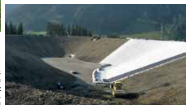
Travaux de Berwang dans le Tyrol
