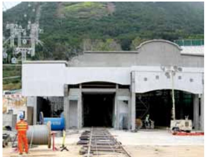
Abb. 1: Talstation der Standseilbahn Ocean Park, davor das Montagegleis zum Einbringen der Züge.
