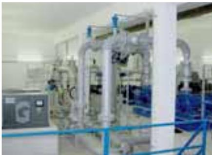
Pumpstation Möseralm in Steinplatte/Waidring: links sind die Kompressoren für die Teichbelüftung zu sehen. Hinten sind die Rückspülfilter und rechts die Hochdruckpumpen.
